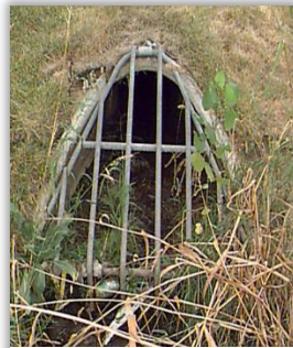
Flared Apron (Concrete)
